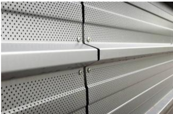
15b Primaire bevestiging van de geperforeerde horizontale binnendoos met zelftappende schroeven of schietnagels aan een stalen kolom
